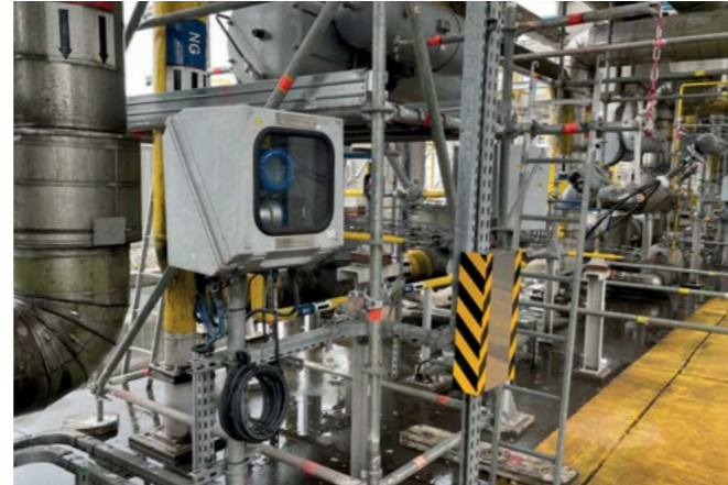
Temperaturgeregeltes Transmitter-Gehäuse für LNG-Terminal.
