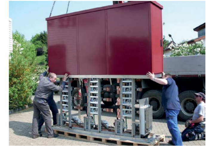
Schutzschrank für Bahnsteuerungsanlagen.
