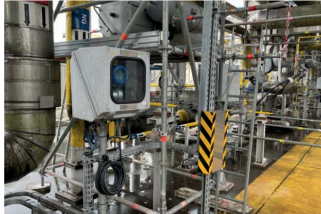
Temperaturgeregeltes Transmitter-Gehäuse für LNG-Terminal.
