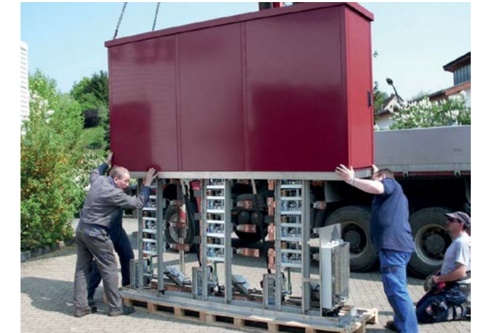
Schutzschrank für Bahnsteuerungsanlagen.
